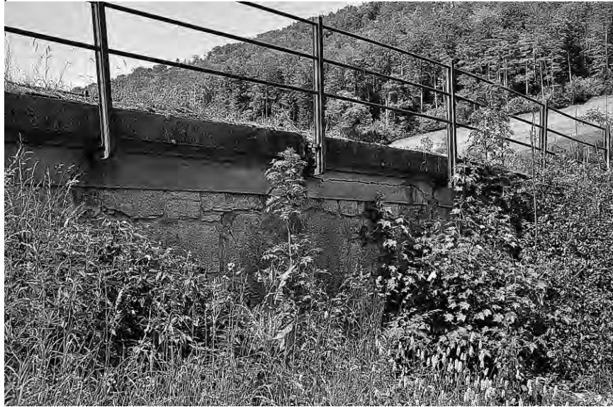
Bilsteinbrücke Vordere Frenke
