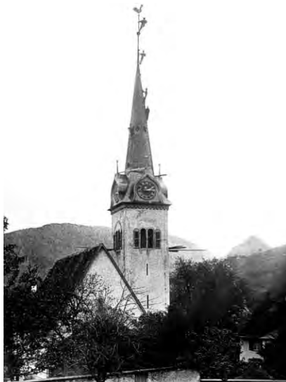
Renovationsarbeiten am Kirchturm der reformierten Kirche; 1925. Teilansicht (zVg Johannes Dettwiler).
