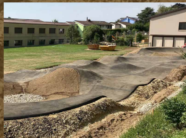
Beispiel fertig eingebauter Asphaltbelag
