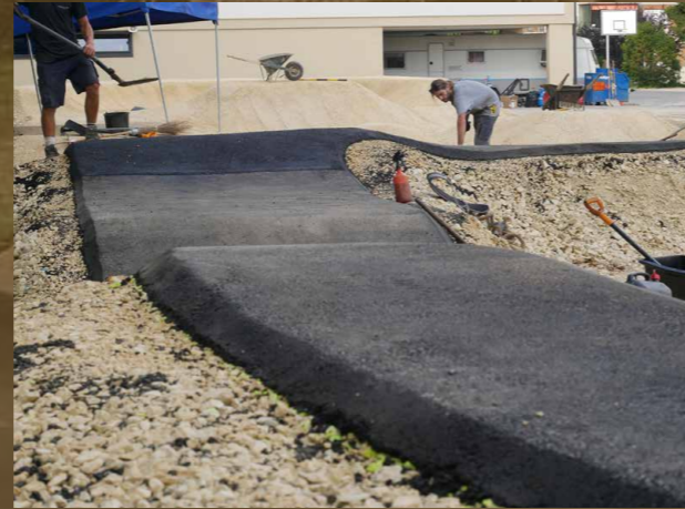
Beispiel richtig geformte und verdichtete Asphaltoberfläche
