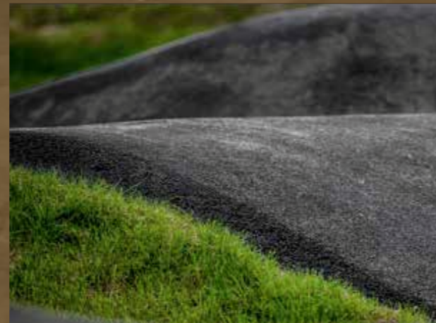
Beispiel richtig eingebauter Belag
