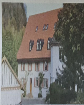
Das historische Haus (rechts) wurde im 16. Jahrhundert erbaut.
