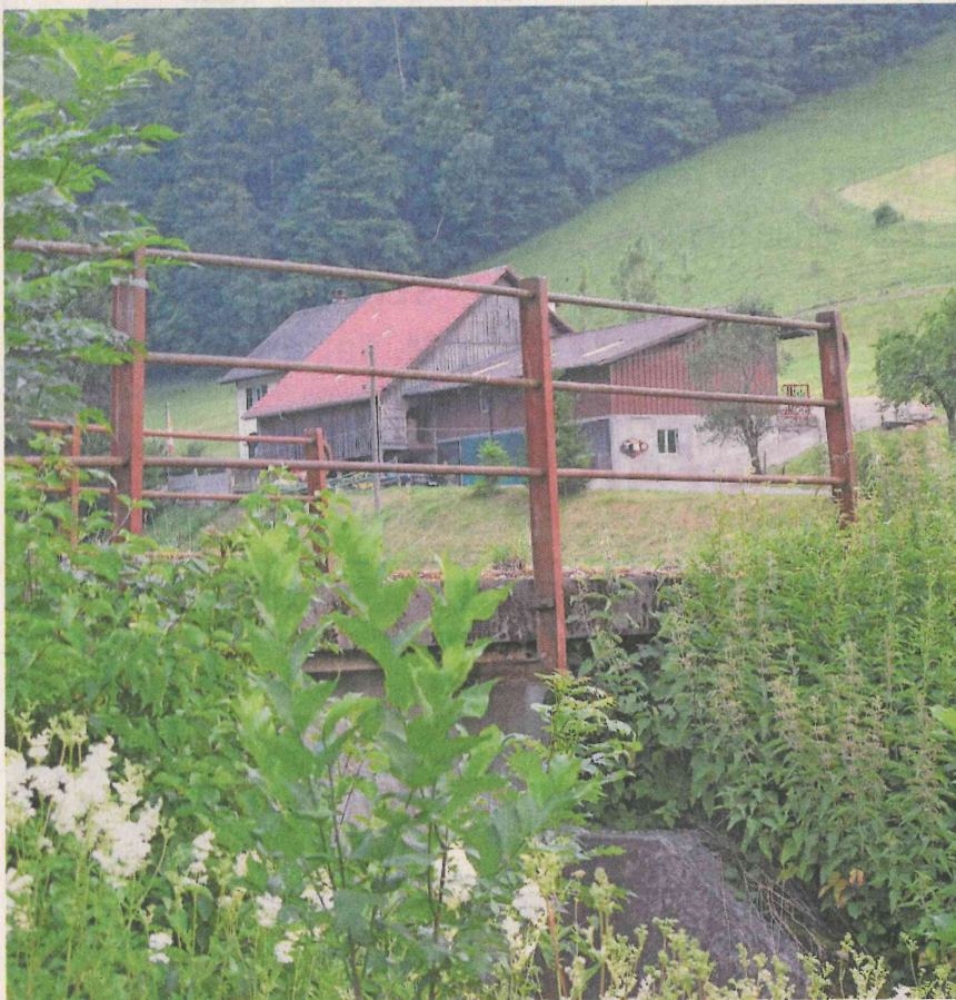
Die Bilsteinbrücke eines von zwölf Sanierungsprojekten.
